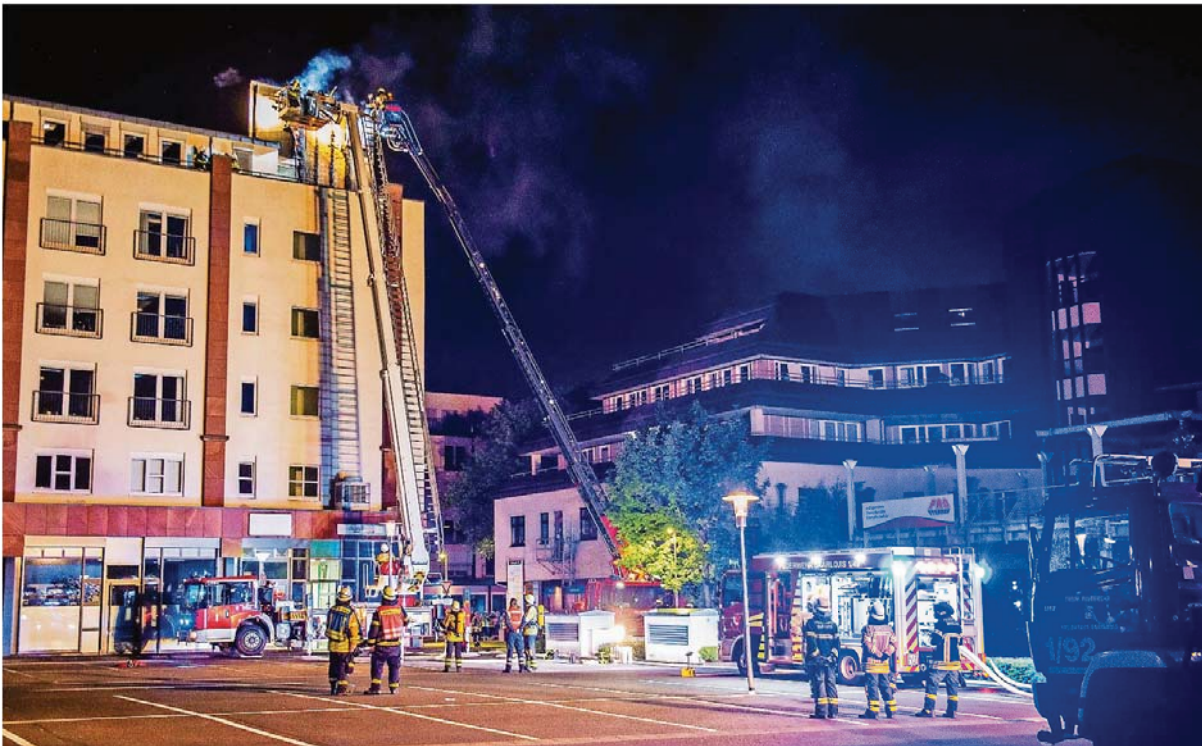
Ein Feuer im Maschinenraum des Fahrstuhls richtete in der Nacht zum Freitag großen Schaden an.
