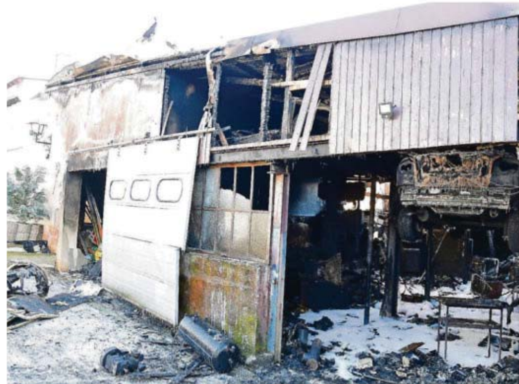
In Steinbach brannte eine Autowerkstatt komplett aus, inklusive dreier Fahrzeuge. Das Feuer bedrohte auch ein Wohnhaus in unmittelbarer Nähe. FOTO: BECKERBREDEL
