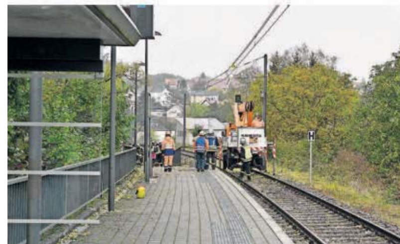
Am Saarbahn-Haltepunkt Lebach-Landsweiler musste ein Baum über der Oberleitung beseitigt werden.
