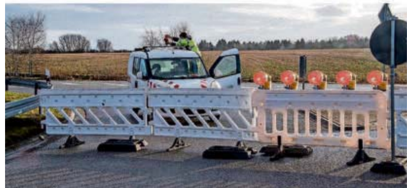
Die B 269 neu zwischen Linslerhof und Überherrn musste gesperrt werden.
