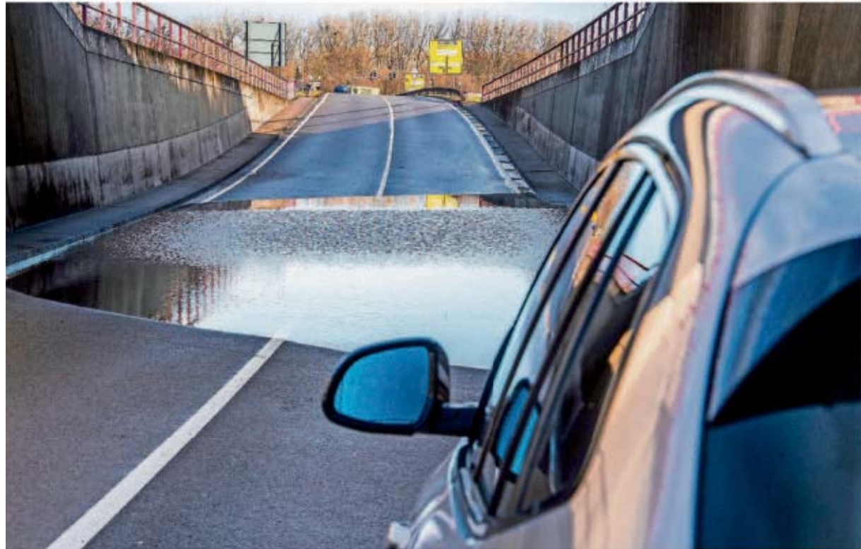
Ein Pumpwerk war ausgefallen, sodass ein Teil der B 269 neu unter Wasser stand.
