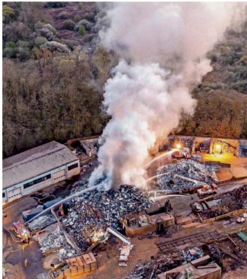
Auf dem Gelände des Stahlwerks Bous hatte ein Schrottlager Feuer gefangen. Die Rauchwolke war über viele Kilometer hin sichtbar.
